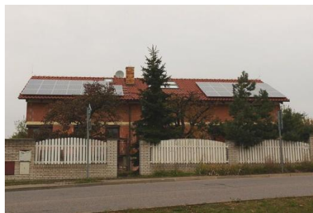
Rodinný dům Praha-Stodůlky FVE 8 kWp, moduly Heckert, střídače Kaco 3600xi
