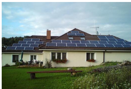
Rodinný dům v obci Družec, okres Kladno FVE 8 kWp, moduly Heckert, střídače Kaco 3600xi
